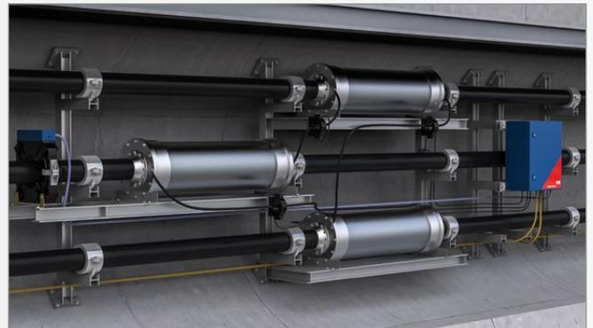
Monitoreo de DP en los empalmes de pantalla cruzada de un sistema de cables tendidos en túneles
