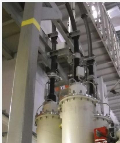
Terminaciones de un sistema de cables enterrados de 380 kV
